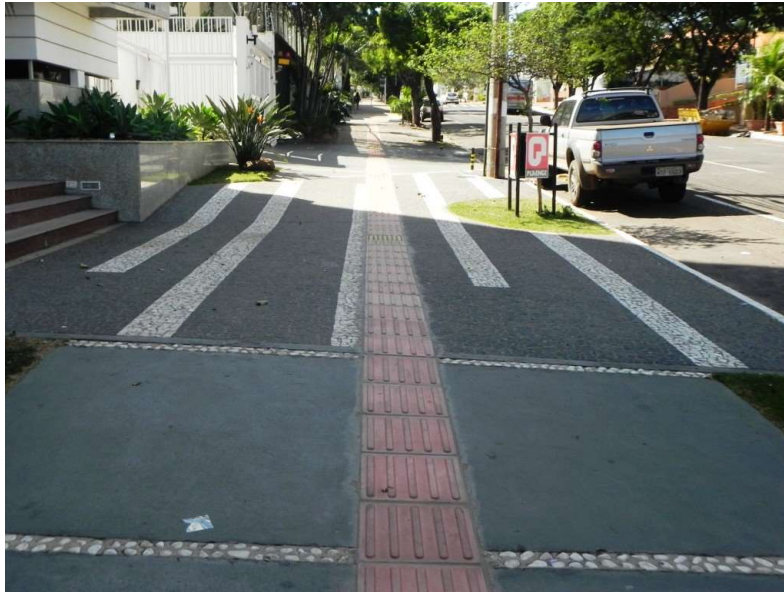
Figura 18: Modelo de continuidade do piso tátil direcional entre lotes
