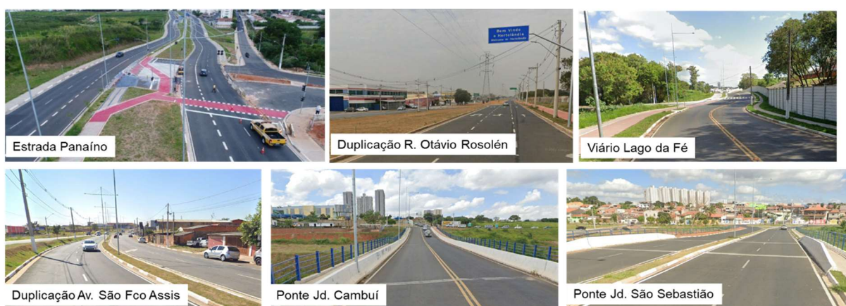
Figura 46: Obras de infraestrutura viária
